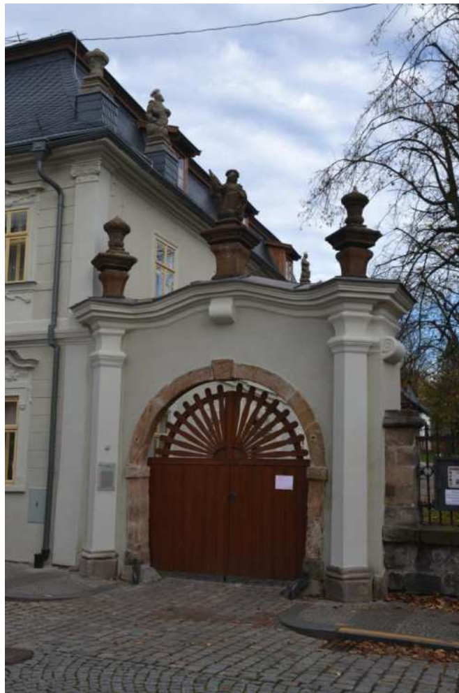
Dům č. p. 70, brána do dvora, foto IP 2014.
