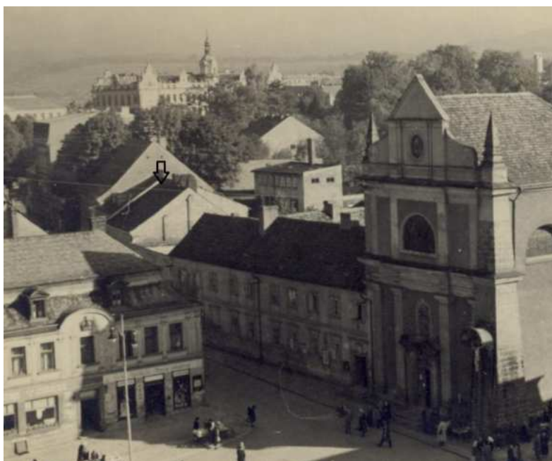
Střecha domu č. p. 66 (vyznačena šipkou) mezi lety 1939 – 1945, (foto sbírka MČR, inv. č. AFT 132_2009-02).
