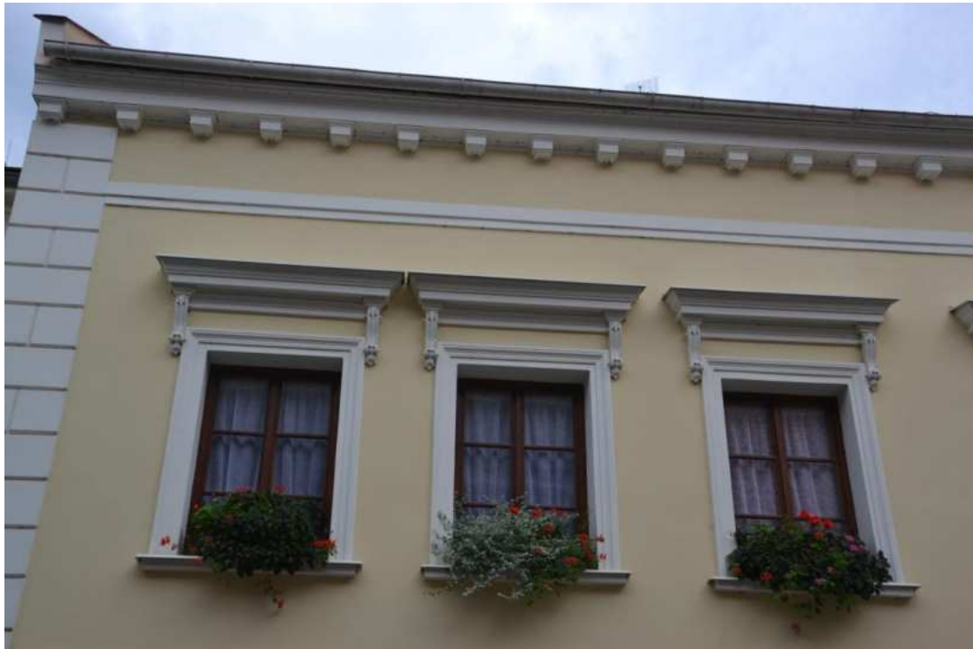
Dům č. p. 66, hlavní západní průčelí, detail oken v levé části patra, foto IP 2013.
