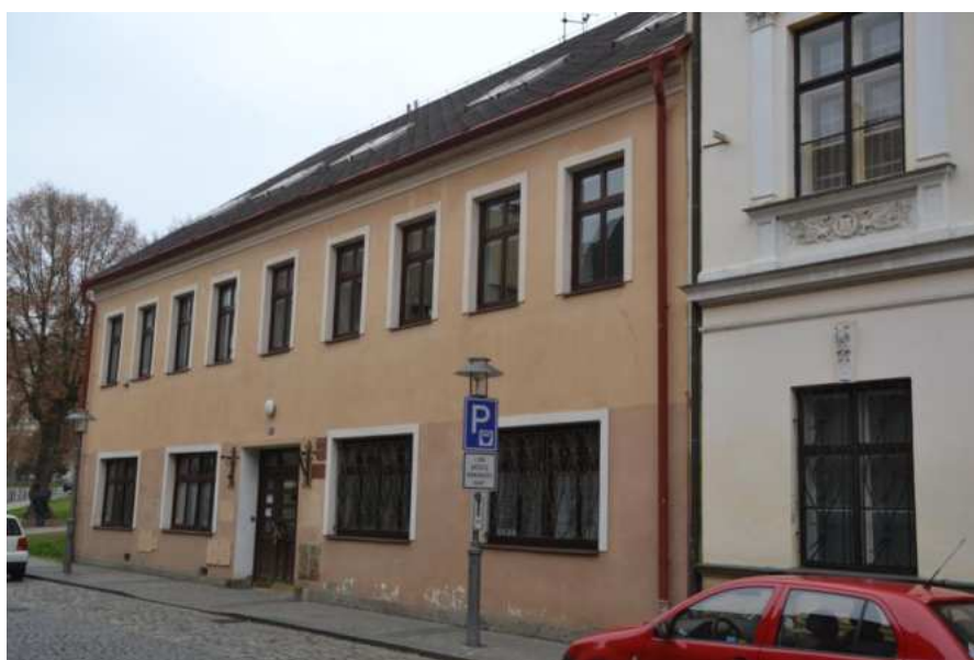
Dům č. p. 72, hlavní západní průčelí, foto IP 2014.
