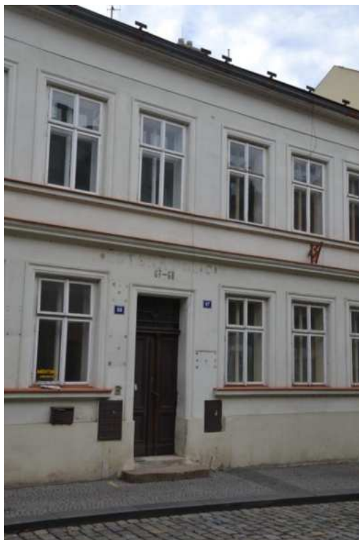
Dům č. p. 67+68, hlavní západní průčelí, detail vstupu, foto IP 2013.
