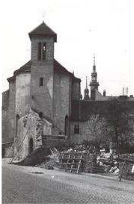
Přetavba téměř zbourané ohradní zdi kolem klášterní zahrady při č. p. 65 v roce 1939, (foto sbírka MČR, inv. č. AFT 330 a).
