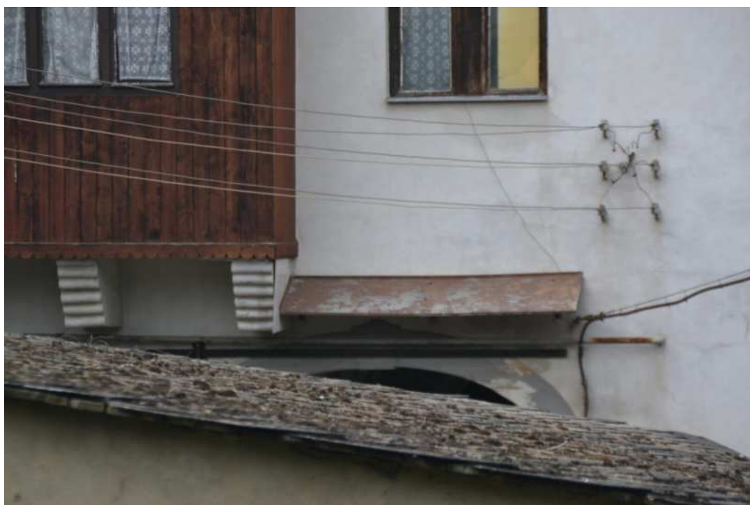
Dům č. p. 69, zadní východní průčelí, detail krakorců pavlače a portálu průjezdu, foto IP 2016.
