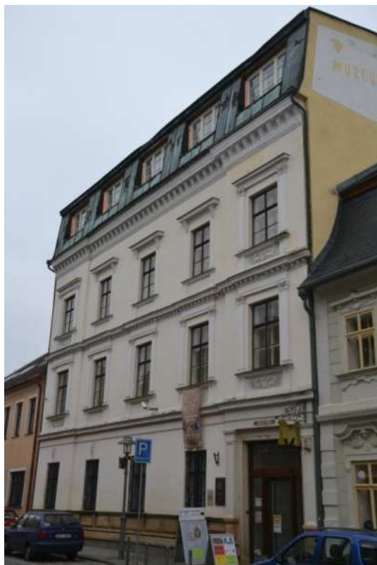
Dům č. p. 71, hlavní západní průčelí, foto IP 2014.
