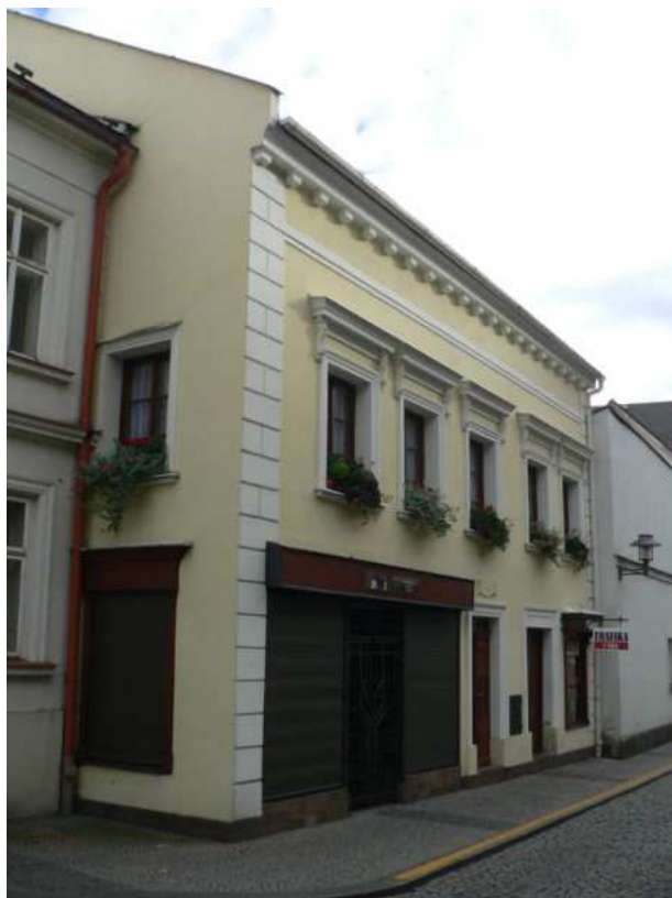
Dům č. p. 66, hlavní západní průčelí a část severního štítového průčelí, foto MK 2013.
