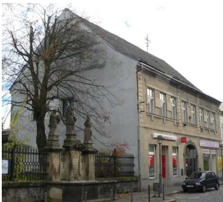
Dům č. p. 69, severní štítové a hlavní západní průčelí, foto MK 2013.
