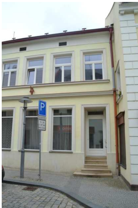
Dům č. p. 67+68, hlavní západní průčelí – detail pravého nového vstupu a nových oken, foto IP 2016.
