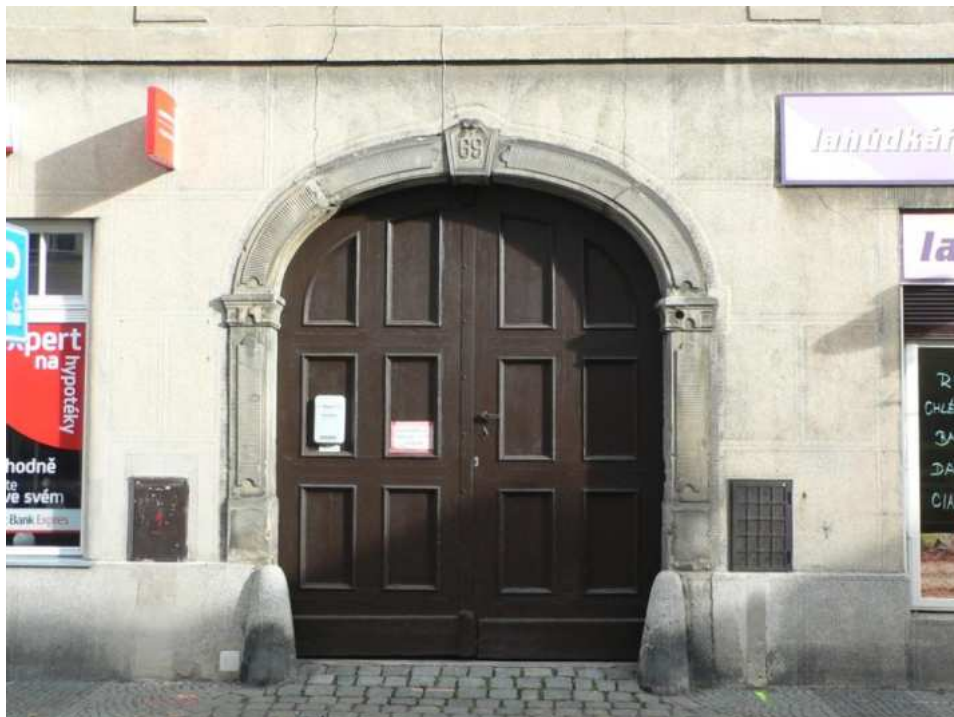
Dům č. p. 69, detail vstupního portálu, foto MK 2013.
