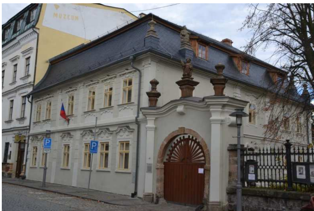
Dům č. p. 70, celkový pohled od jihozápadu, foto IP 2014.
