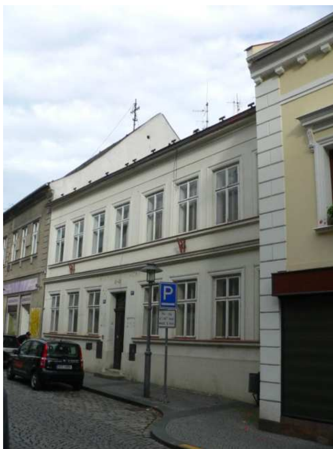
Dům č. p. 67+68, hlavní západní průčelí, foto MK 2013.
