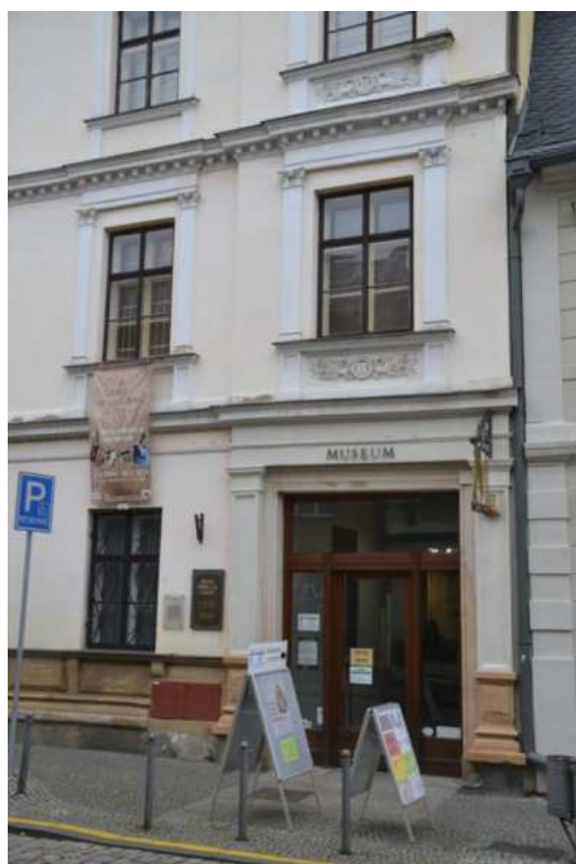
Dům č. p. 71, hlavní západní průčelí – detail vstupu, foto IP 2014.
