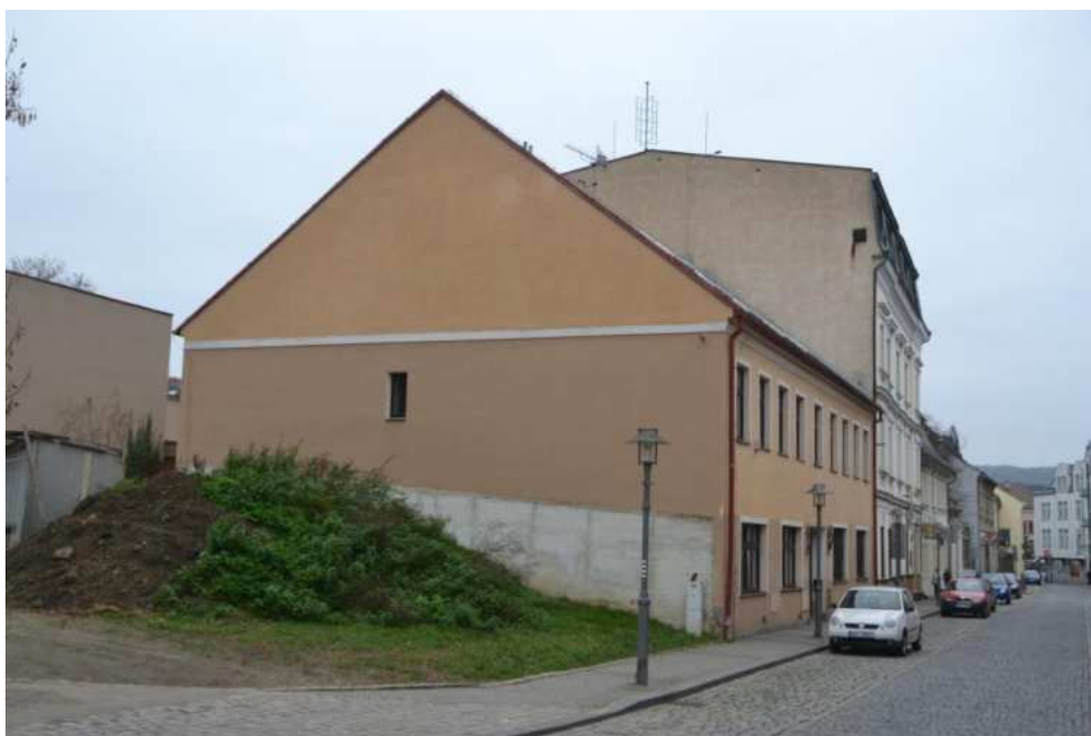
Dům č. p. 72, severní štítové průčelí, foto IP 2014.
