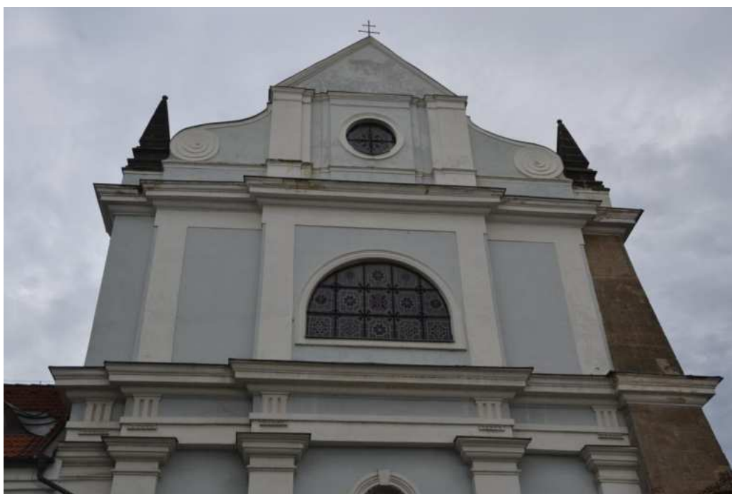
Kostel sv. Františka z Assisi, detail štítu západního průčelí, foto IP 2013.
