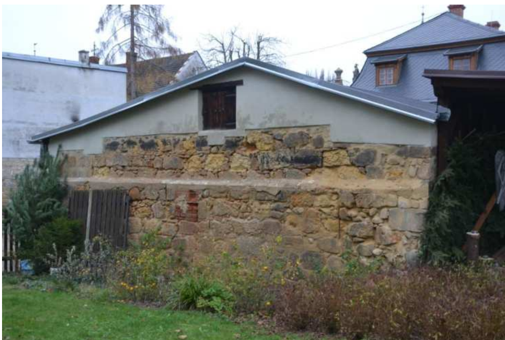
Dům č. p. 70, zdivo garáží, foto IP 2014.
