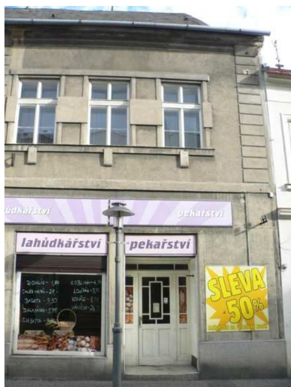
Dům č. p. 69, pravá část hlavního západního průčelí, foto MK 2013.
