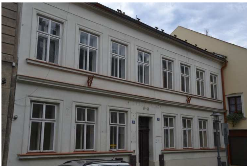
Dům č. p. 67+68, hlavní západní průčelí, foto IP 2013.
