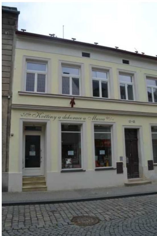
Dům č. p. 67+68, hlavní západní průčelí – detail levého nového vstupu a nových oken, foto IP 2016.
