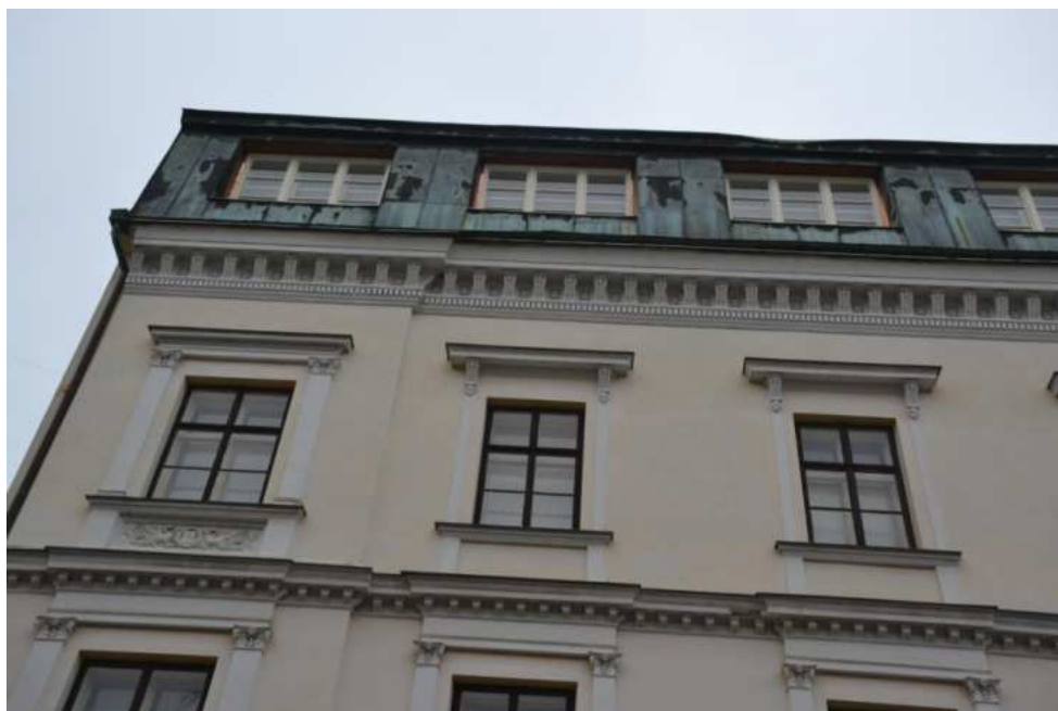
Dům č. p. 71, hlavní západní průčelí – detail fasády, foto IP 2014.
