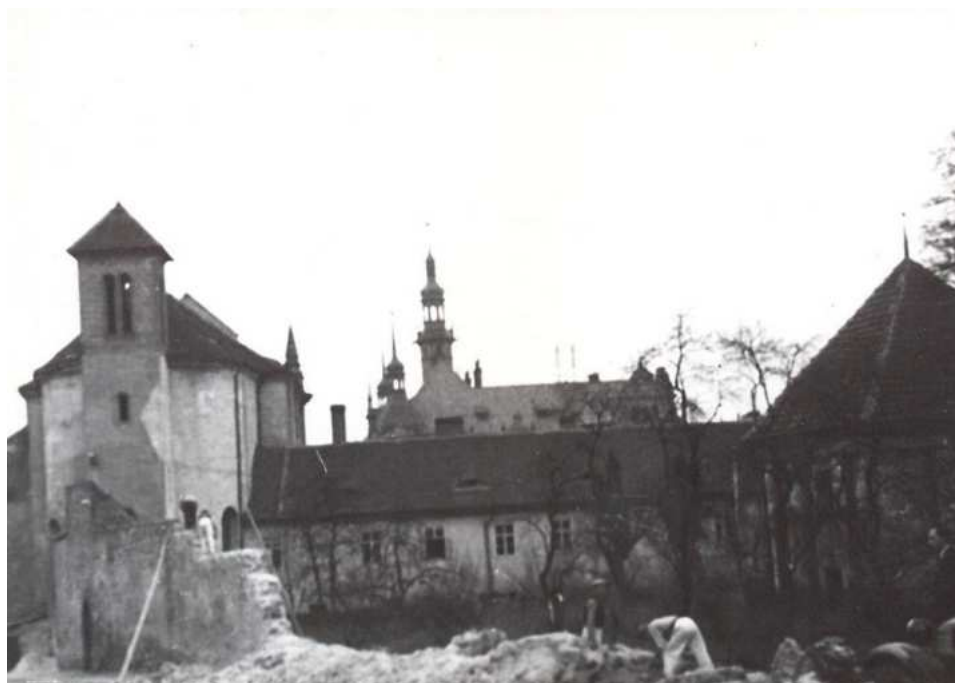
Přetavba téměř zbourané ohradní zdi kolem klášterní zahrady při č. p. 65 v roce 1939, (foto sbírka MČR, inv. č. AFT 330 b).
