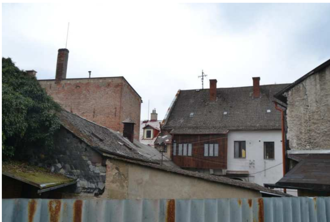
Dům č. p. 69, zadní východní průčelí a dvorní přístavba s odvětrávacím nástavcem ve střeše, foto IP 2016.
