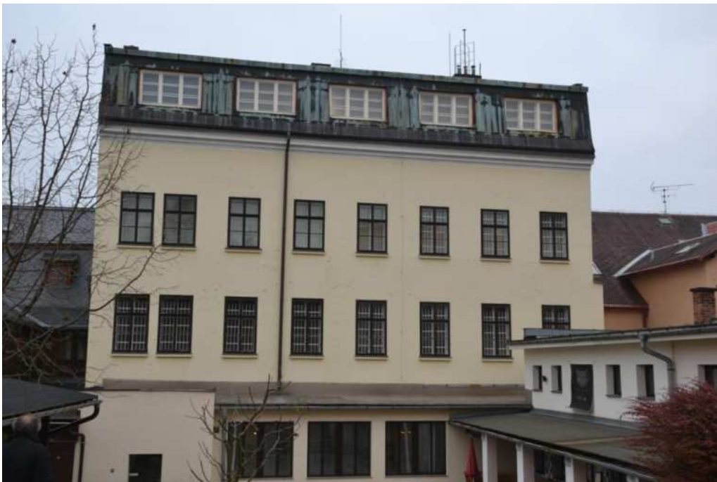
Dům č. p. 71, zadní východní průčelí, foto IP 2014.
