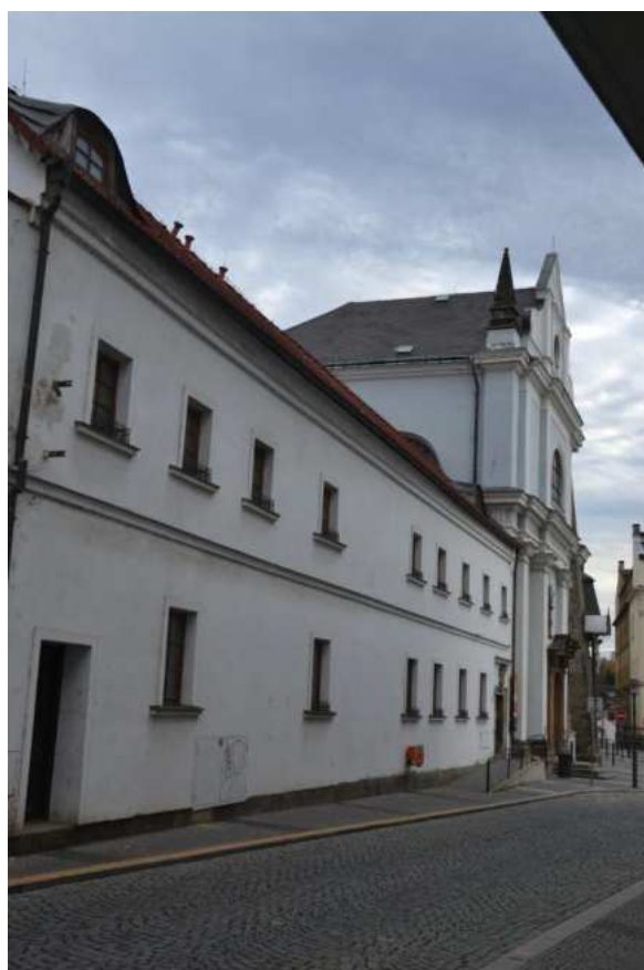
Klášter č. p. 65, hlavní západní průčelí, foto IP 2013.
