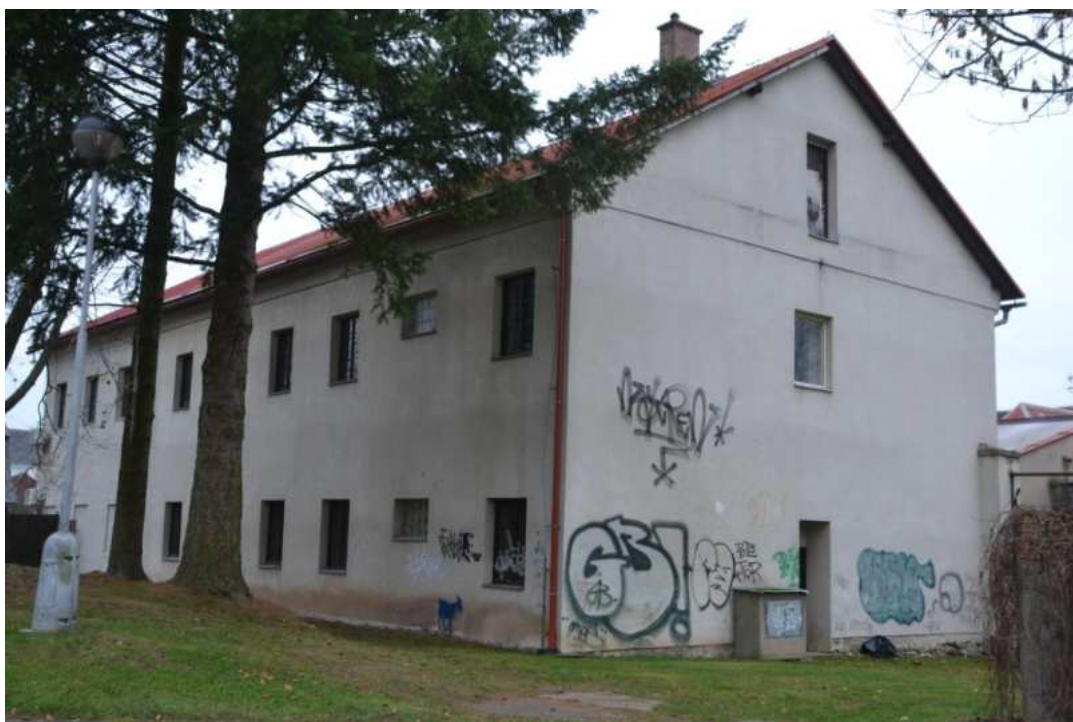
Zadní objekt bývalé věznice od severovýchodu, foto IP 2014.
