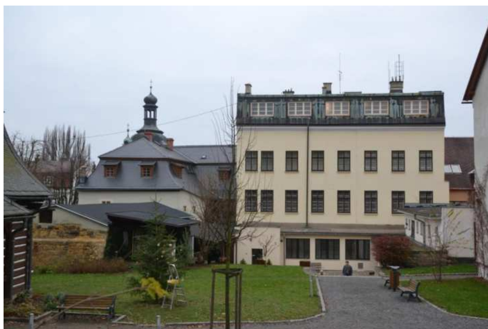
Dům č. p. 71, celkový pohled na dvůr a zadní východní průčelí, foto IP 2014.
