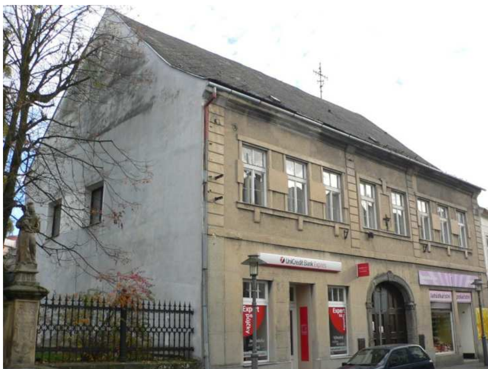
Dům č. p. 69, severní štítové a hlavní západní průčelí, foto MK 2013.
