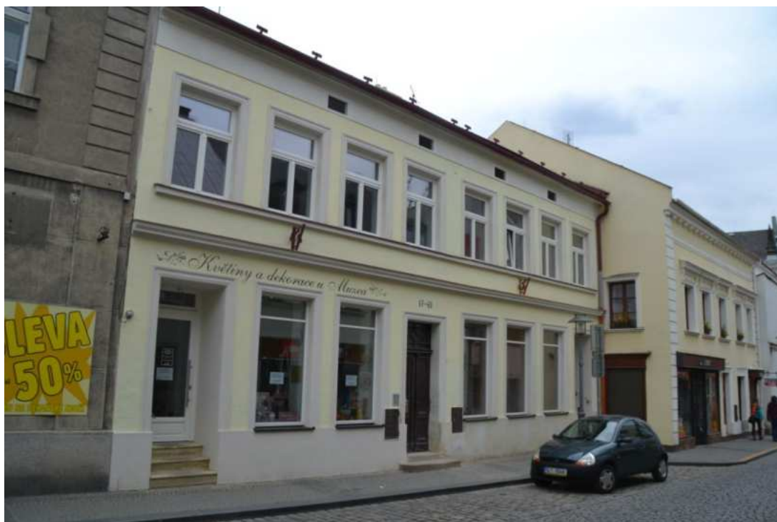
Dům č. p. 67+68, hlavní západní průčelí během stavebních úprav, foto IP 2016.
