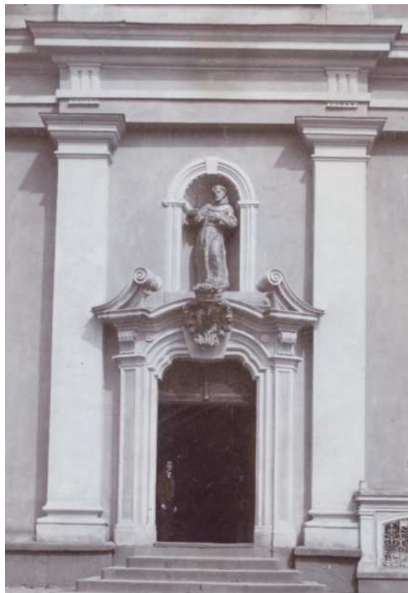
Kostel sv. Františka z Assisi, hlavní vstup do kostela v západním průčelí v roce 1890, (foto sbírka MČR, inv. č. AFT 801 a).
