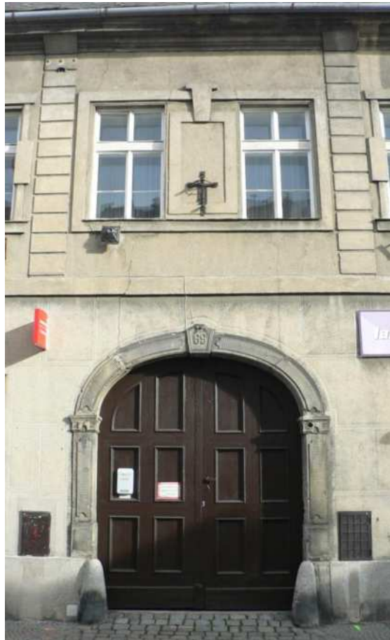
Dům č. p. 69, detail vstupní partie hlavního západního průčelí, foto MK 2013.
