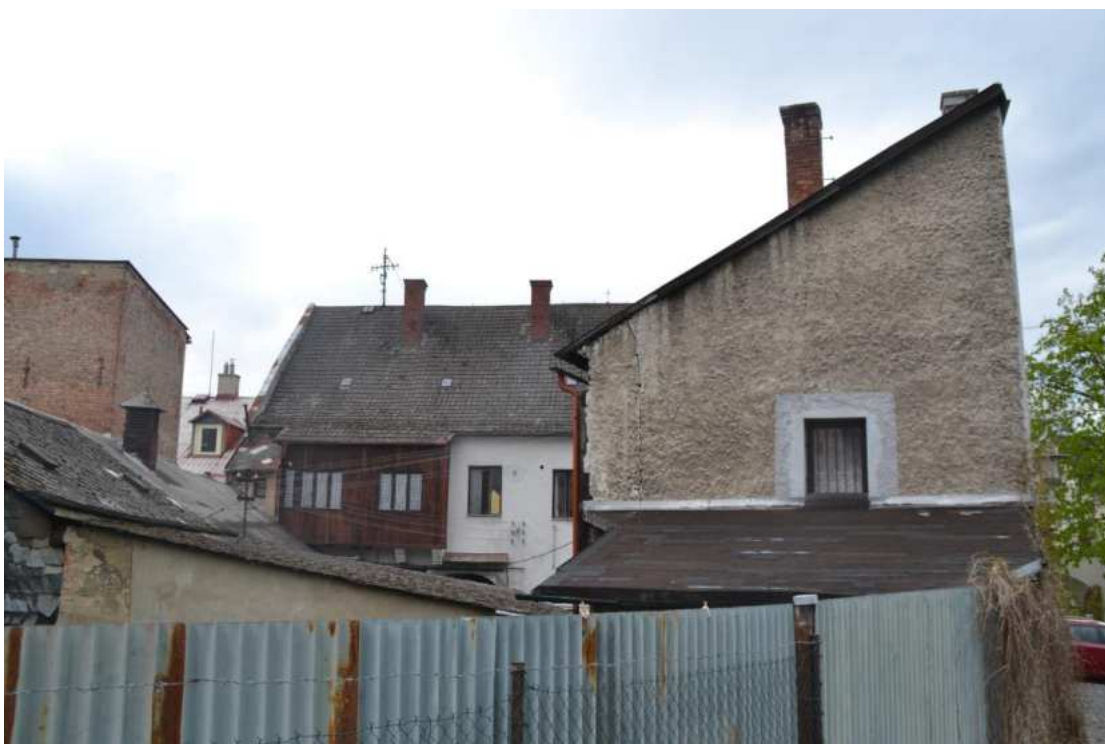
Dům č. p. 73, východní štítové průčelí, foto IP 2016.
