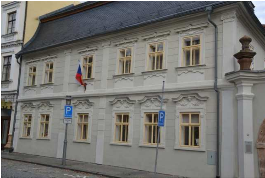
Dům č. p. 70, hlavní západní průčelí, foto IP 2014.
